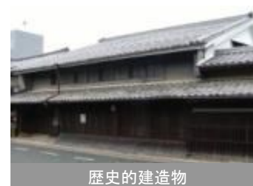
伝統的建造物群保存地区保存修理事業
