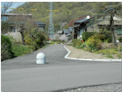
地元住民により管理されている ちんちん電車遊歩道
