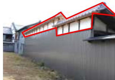
大石家屋根塀附属屋 (修理後)
