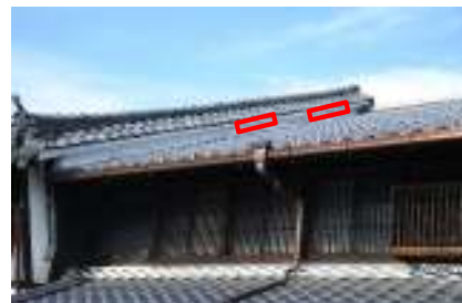
大石家主屋(修理後)
