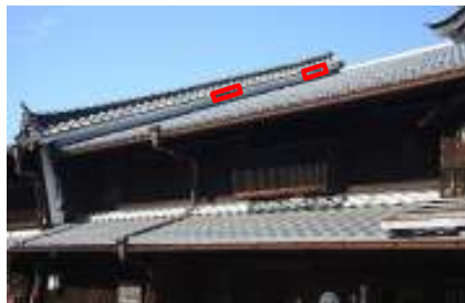
大石家主屋(修理前)
