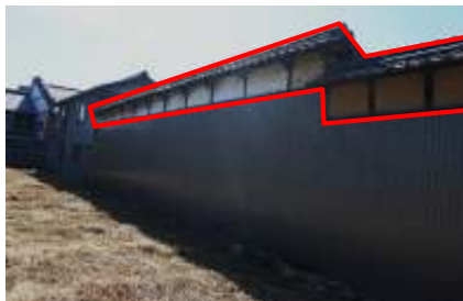
大石家屋根塀附属屋 (修理前)
