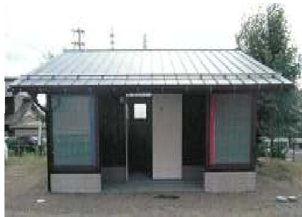
旧名鉄美濃町線美濃駅前広場トイレ新設
