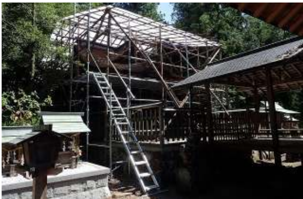
真木倉神社 本殿 保存修理
