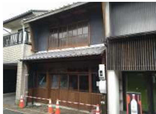
直井家 主屋 修理
