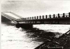
昭和51年 上野・陸橋の落橋
