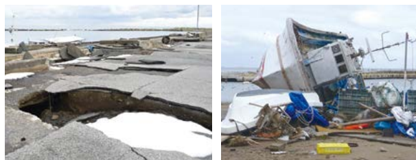
▲能登半島地震直後の珠洲市の様子 (石川県のホームページより)
